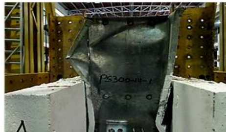
(d) CFS flange buckling
